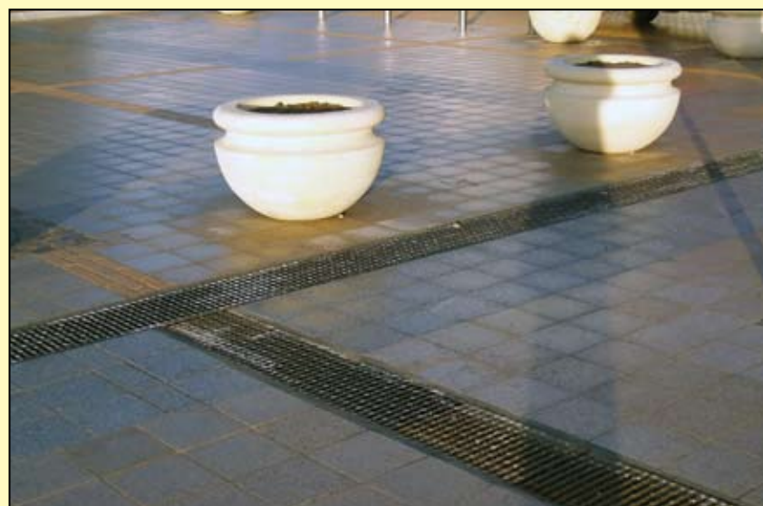
Kratki kanalizacji deszczowej wbudowane w nawierzchnię Pl. Jana Pawła II
