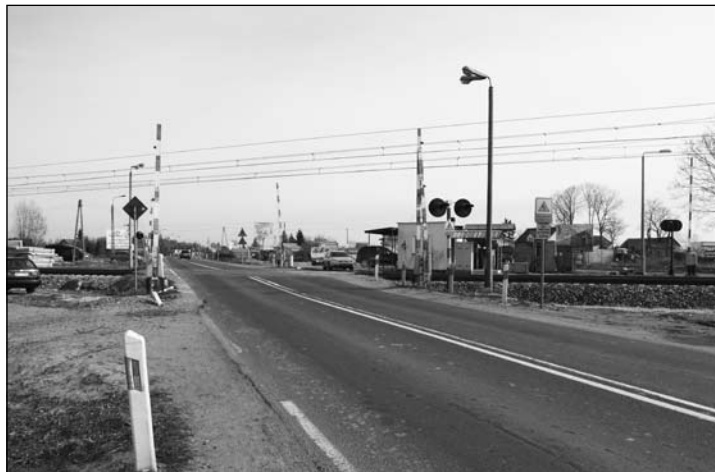
Przejazd kolejowy na ul. Kasprzaka
