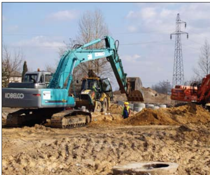
Prace na odcinku między ul. Niechodzką i Mleczarską
