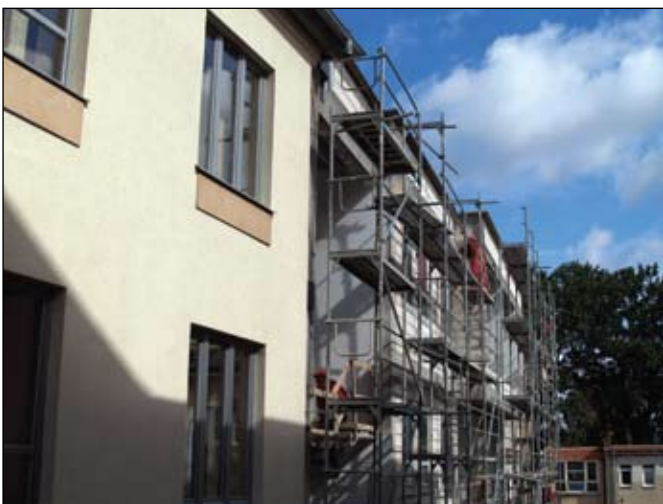
Rusztowania przeniesiono teraz na wschodnią elewację
