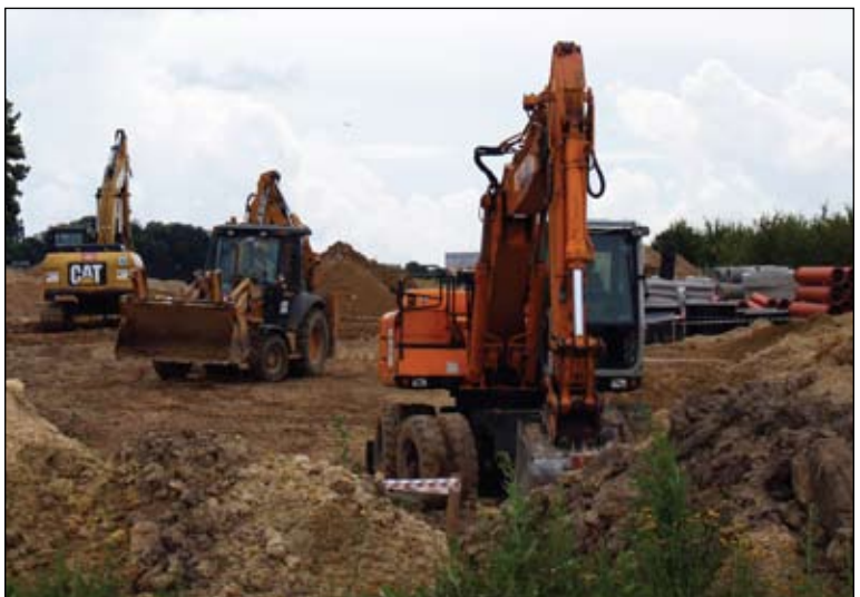
Fragment pętli widziany od strony ul. Gostkowskiej. Ekipa Eurovii buduje tu kanalizację deszczową. Roboty wznowiono po zakończeniu prac wykopaliskowych. Archeolodzy znaleźli tu ślady naszych przodków: osady z epoki brązu (III-II tysiąclecie p.n.e.), a w części między rzeką i ul. Wojska Polskiego – z XV-XVII w.
