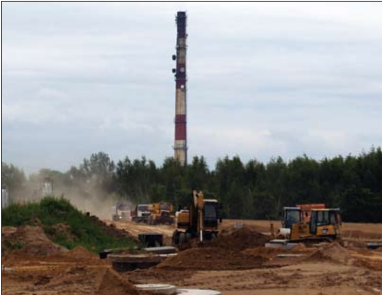
Odcinek między ulicami Płocką i Niechodzką – widok od strony Płockiej. Trwa zagęszczanie nasypu. Niedługo rozpocznie się układanie krawężników. Ta część pętli ma być oddana najwcześniej.
