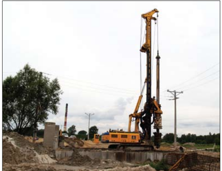
Budowa mostu na Bielinie. Duże wrażenie robi urządzenie do montażu pali pod konstrukcję mostu. Ogromna maszyna ze świdrem nawierca otwory w ziemi i przygotowuje je do umieszczenia owalnych form oraz zbrojenia pali, następnie przygotowane formy zalewa się betonem. Na odcinku między ul. Tysiąclecia i mostem zakończyła się budowa kanalizacji deszczowej.
