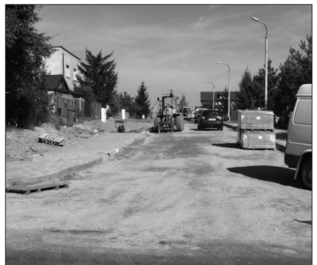
A.G. Wykonano już część chodnika w ul. Jasnej
