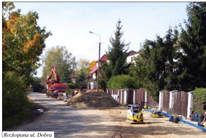
Rozkopana ul. Dobra
