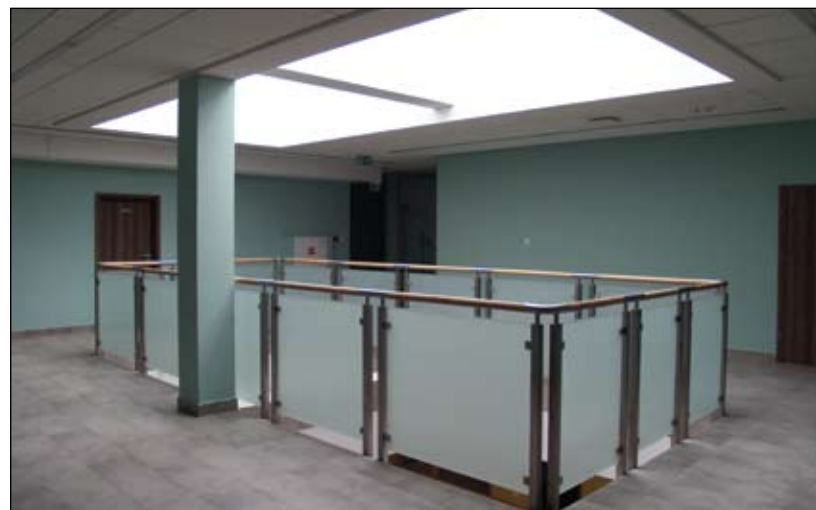
Świetlik z samoczyszczącego szkła zamontowany w dachu zapewni dostęp dziennego światła
