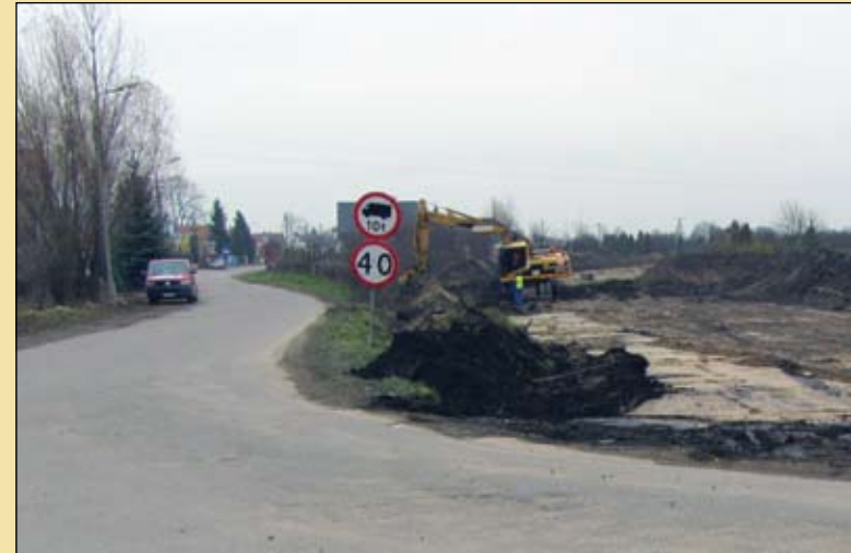
Prace na odcinku od ul. Śmiecińskiej
