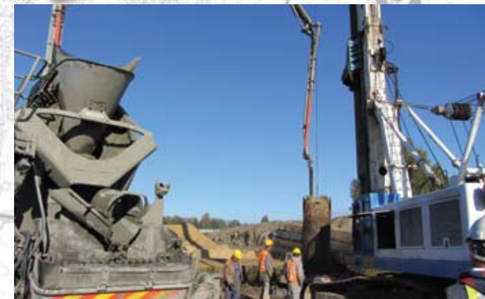
Ruszyła budowa mostu północnego na Łydyni (między ul. Gostkowską i Wojska Polskiego)
