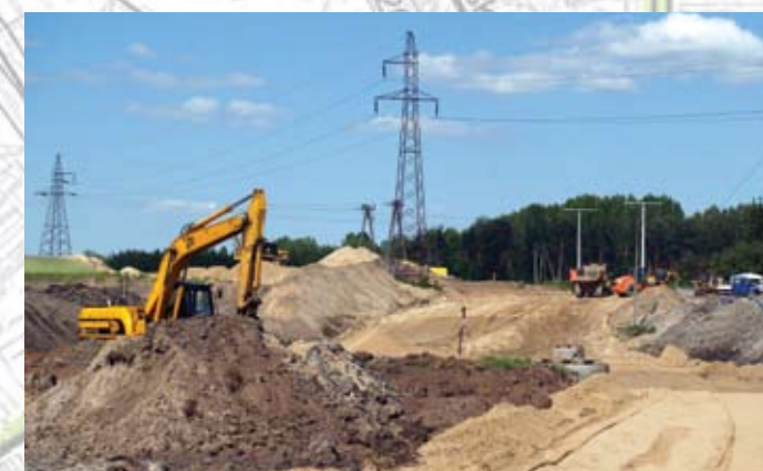
Prace na Bielnie
