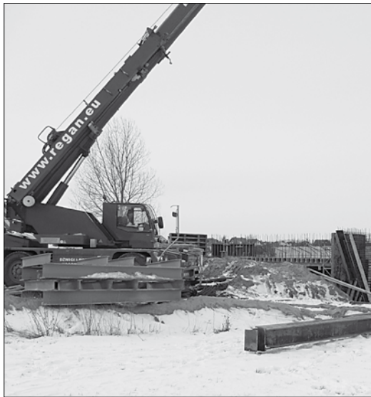
Budowa mostu północnego
