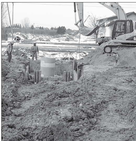
Budowa kanalizacji deszczowej między ul. Pułtuską a Wojska Polskiego
