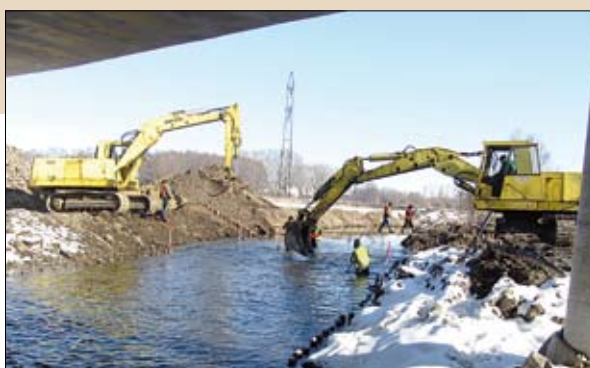
Umacnianie brzegów rzeki po obu stronach mostu południowego na Bielinie
