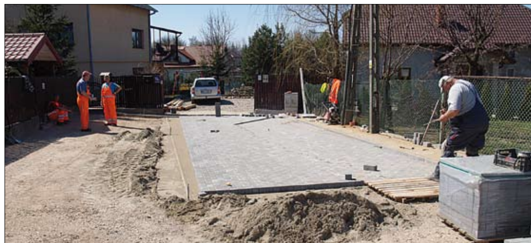
W odnodze ul. Piwnej układana jest kostka brukowa
