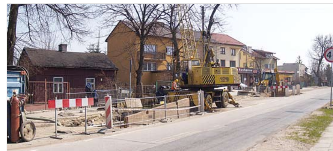
Trwają prace ZWiK nad budową kanalizacji sanitarnej
