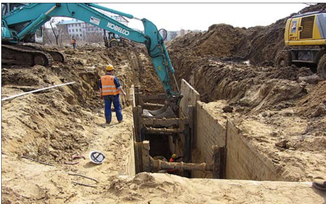
Budowa kanalizacji deszczowej w rejonie ul. Wojska Polskiego i Pułtuskiej
