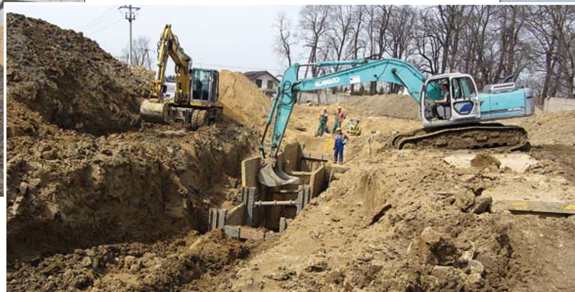
Na odcinku od ul. Wojska Polskiego do Pułtuskiej trwają prace przy kanalizacji deszczowej
