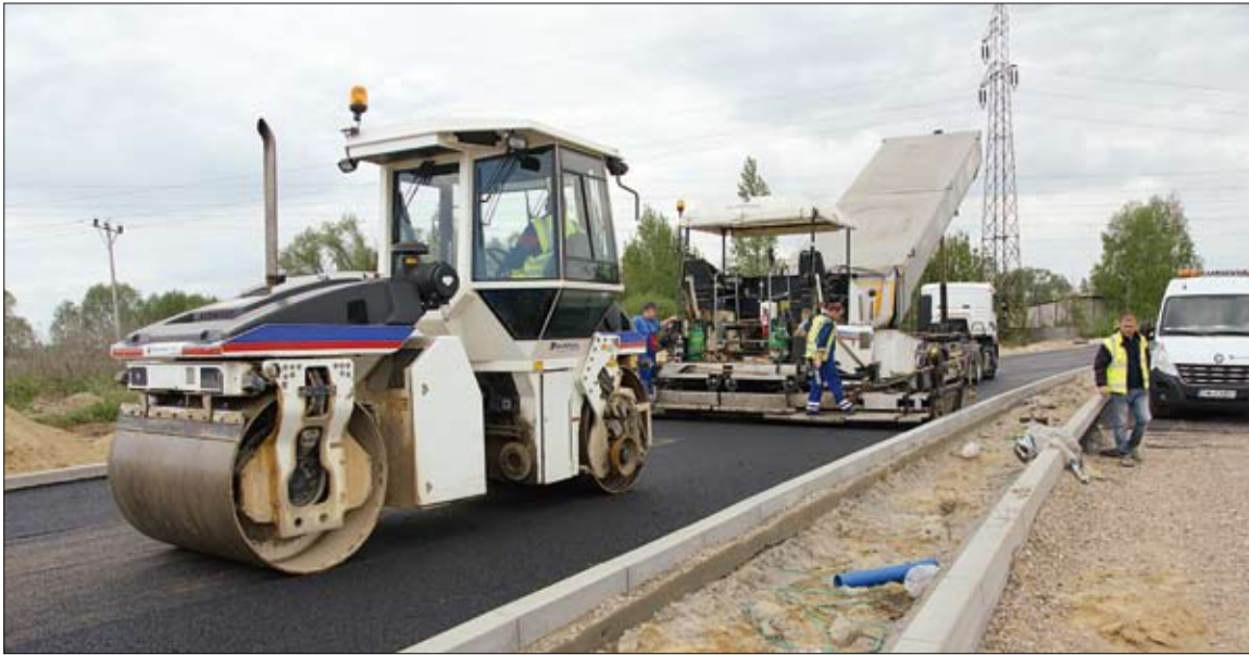
Wylewanie asfaltu pomiędzy ul. Tysiąclecia a Płocką
