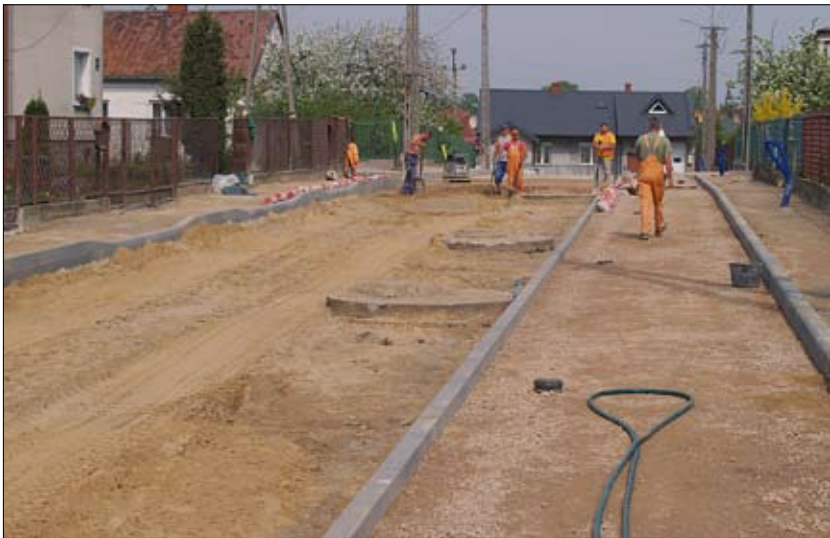
Układanie kręweżników i kostki w ulicy Piwnej
