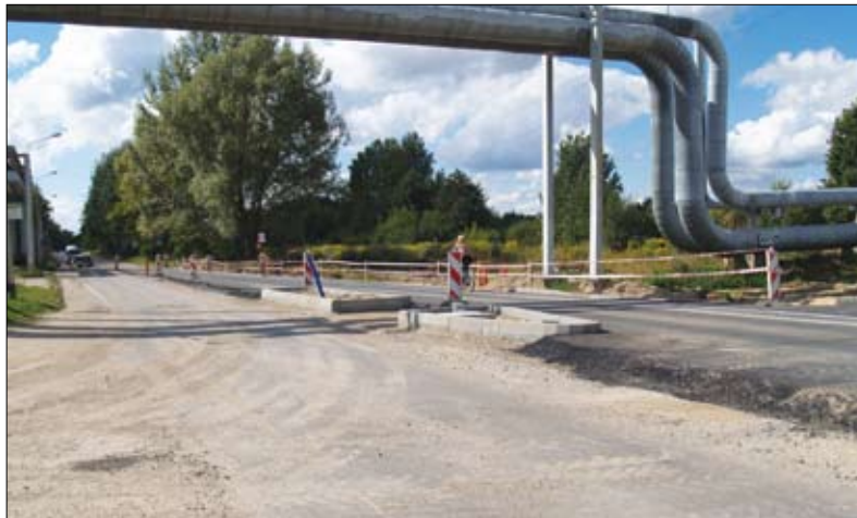
W trakcie budowy jest skrzyżowanie łączące ul. Niechodzką z nowopowstałymi odcinkami pętli
