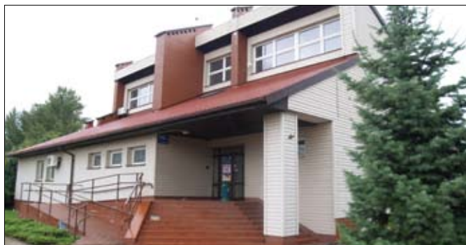
Budynek przy ul. 17 Stycznia 56A
