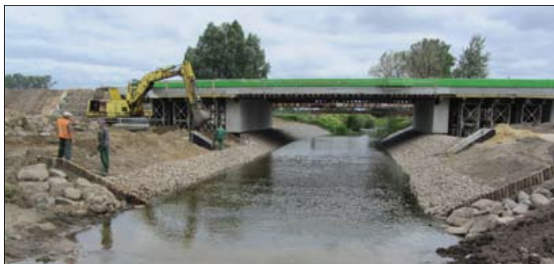
Umocnianie brzegów Łydni przy moście północnym
