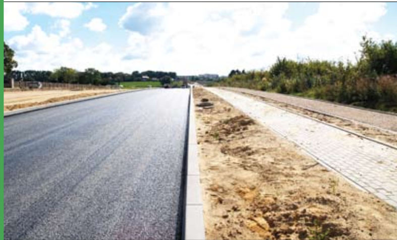
Miedzy ulicą Gostkowską a mostem północnym drogowcy położyli pierwszą warstwę asfaltu
