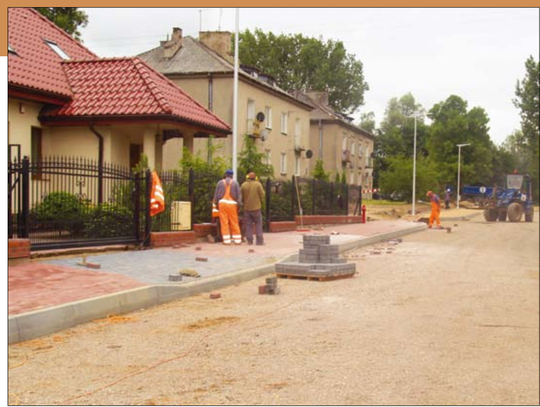
Ulica Krubińska – układanie chodników
