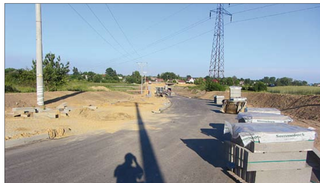
Trwa układanie chodników od ul. Tysiąclecia do mostu na Bielinie
