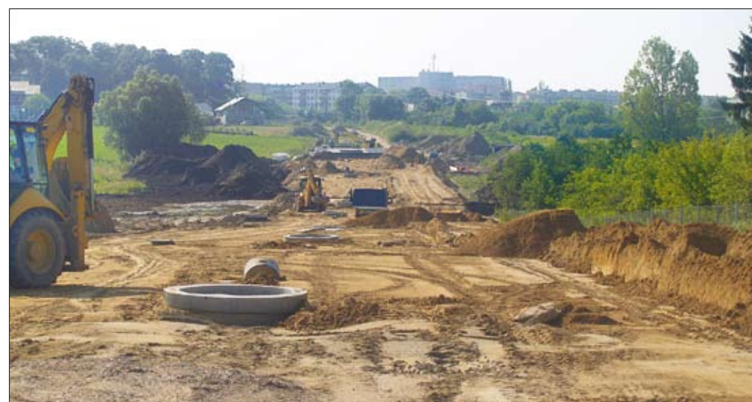
Drogowcy budują dojazdy do mostu północnego
