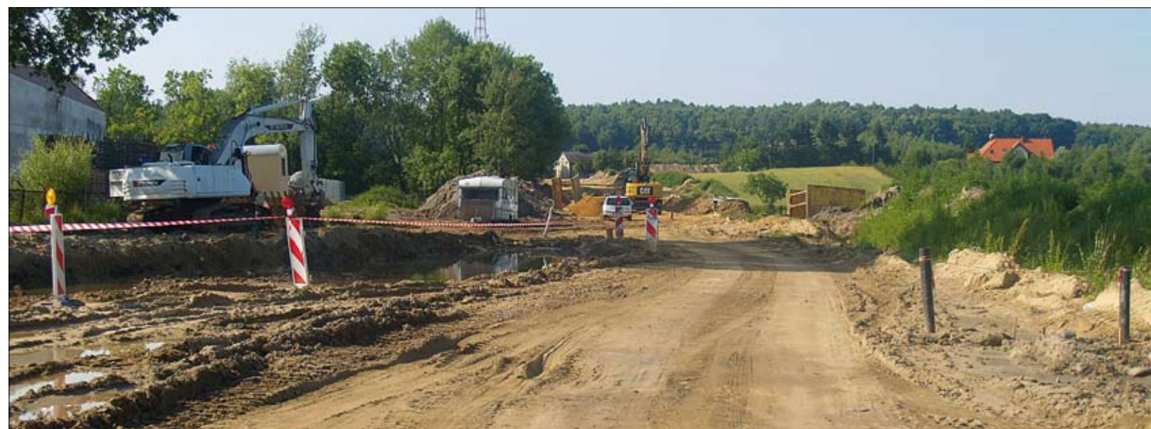
Na odcinku pomiędzy ul. Leśną a Śmiecińską kładziona jest kanalizacja deszczowa
