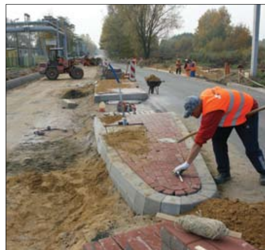
Budowa skrzyżowania pętli z ul. Niechodzką
