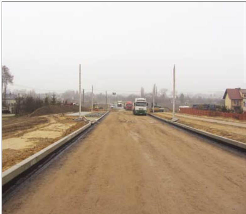
Od ul. Klonowskiego do Monte Cassino drogowcy stabilizują podłoże
