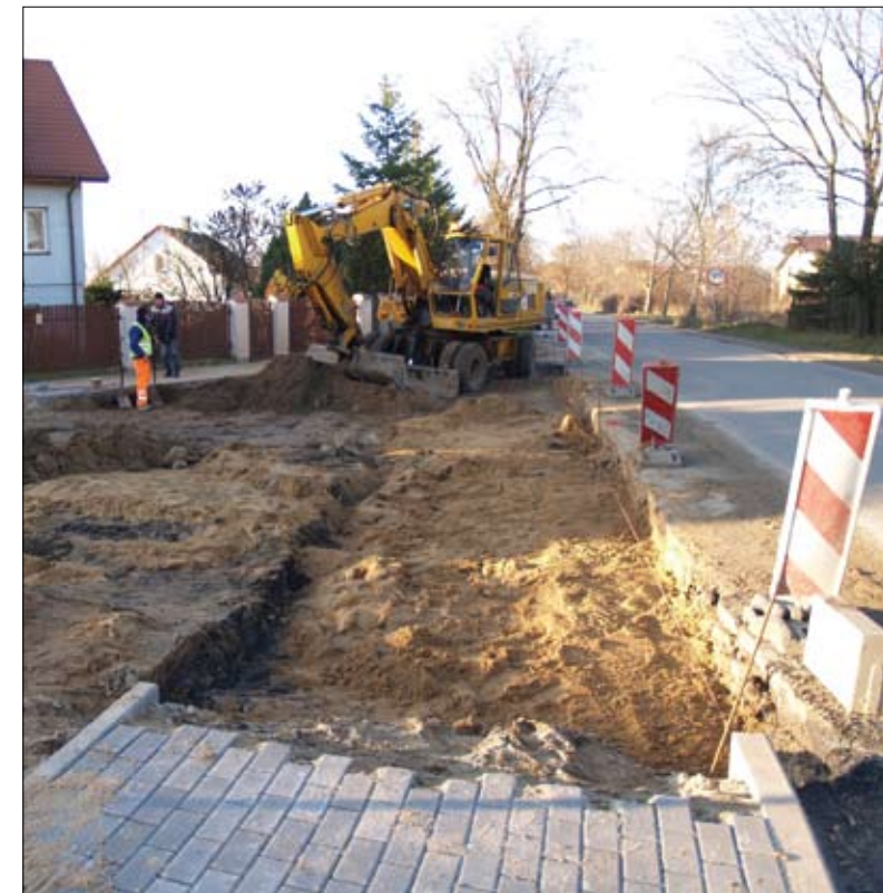
Ulica Krubińska – końcowe prace u zbiegu ul. Sońskiej
