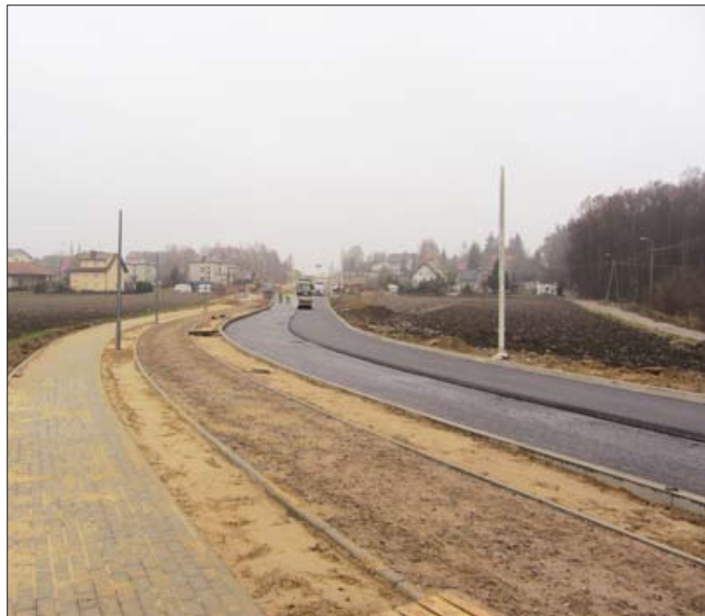
Układanie warstwy wiążącej między ul. Klonowskiego a Leśną
