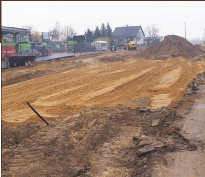
Formowanie nasypu do wiaduktu w ul. Gąseckiej
