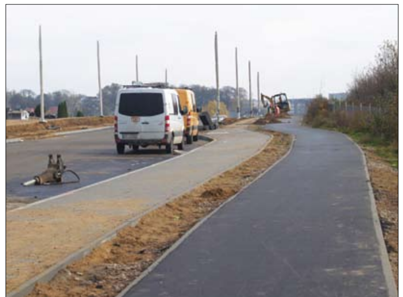
Na powstających odcinkach pętli miejskiej ścieżki rowerowe będą pokryte asfaltową nawierzchnią
