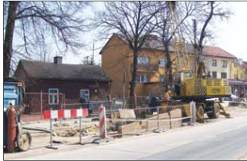
Budowa kanalizacji sanitarnej w ul. Płońskiej
