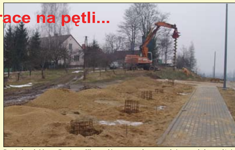
Pomiędzy ul. Monte Cassino a Klonowskiego prowadzone są odwierty pod ekrany dźwiękochłonne
