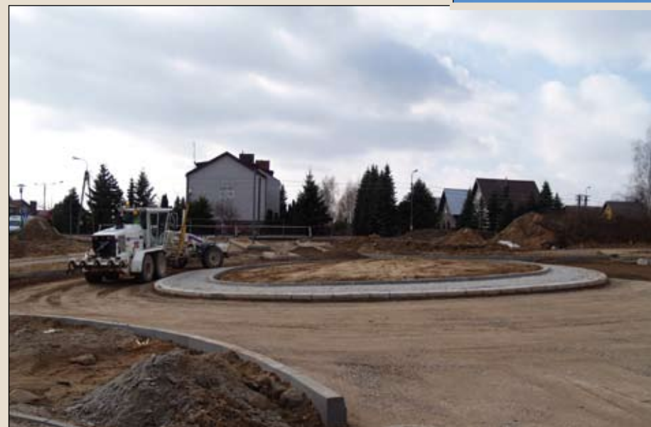
Wyrównywanie podłoża przy rondzie w okolicy hotelu Atena
