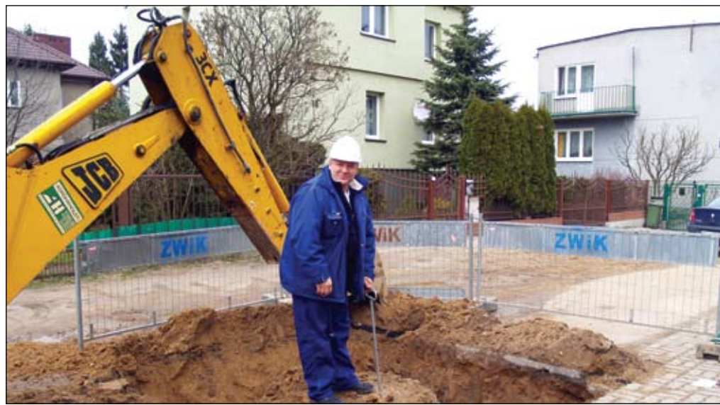
W ulicy Klonowej ZWiK wymienia studzienki kanalizacyjne
