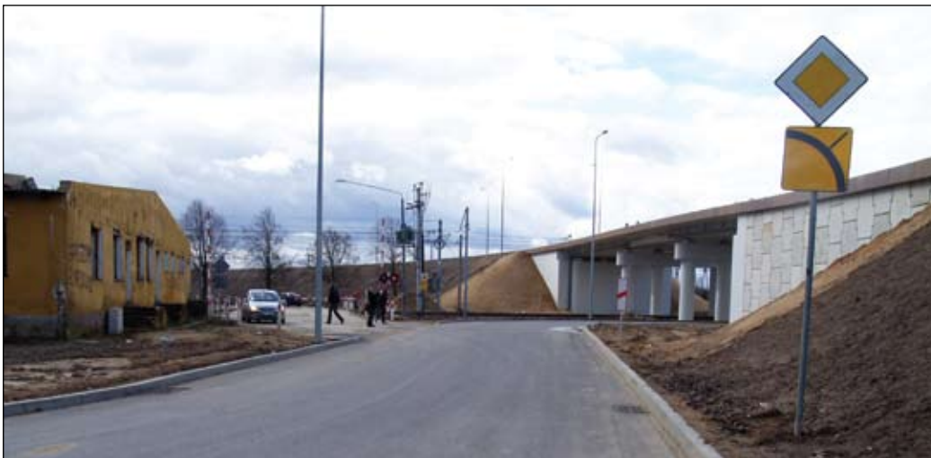
Droga dojazdowa do przejazdu na ul. Gąseckiej została w tym roku wyremontowana przez miasto i WARBUD
