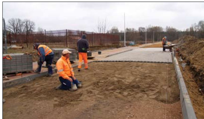
... i jej odnodze układane są krawężniki i chodnik z brukowej kostki
