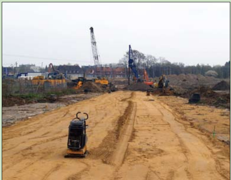
Warbud – wykonawca wiaduktu kolejowego w ul. Spółdzielczej i Śmiecińskiej buduje dojazd do wiaduktu od strony ulicy Starowiejskiej.
