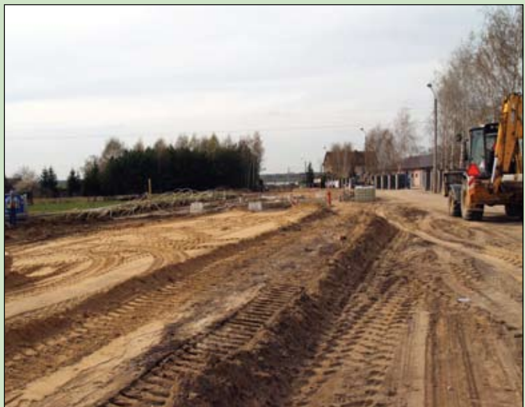
Odcinek ulicy Bielińskiej. Wysoki poziom wód gruntowych obniżany jest przez zastosowanie tzw. igłofiltrów. Niebawem rozpocznie się układanie podbudowy pod nową jezdnię.
