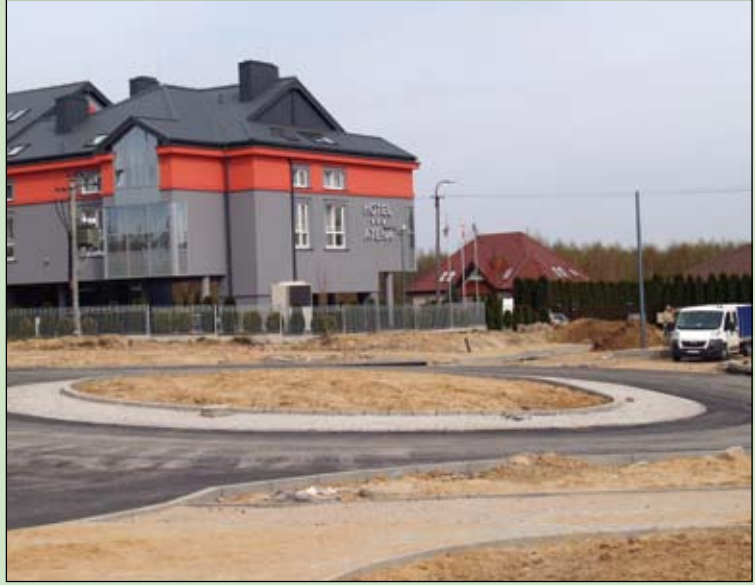
Nowe rondo w okolicy hotelu Atena na osiedlu Zachód pozwoli skomunikować pętlę z ulicami: Kolbego, Bogusławskiego i Różyckiego.
