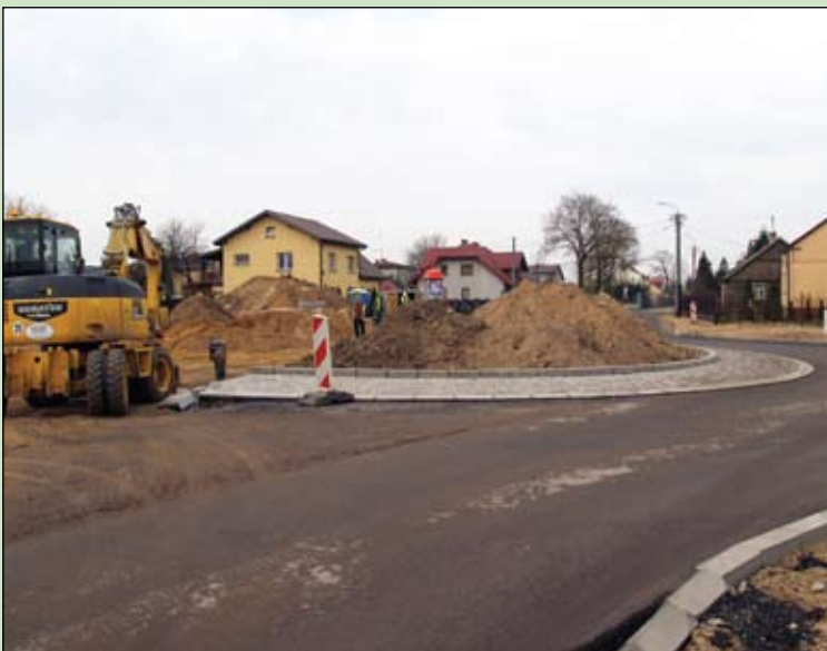
Rondo w ulicy Kwiatowej. Połowa ronda jest już wykonana, druga połowa ma powstać pod koniec maja. Eurovia czeka na zakończenie budowy kanalizacji przez ZWiK.
