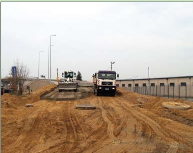
Powstaje połączenie pętli z wiaduktem w ulicy Gąseckiej. PKP PLK obiecuje oddanie go do użytku w lipcu. Drogowcy z Eurovia muszą do tego czasu skomunikować wiadukt z fragmentami pętli.
