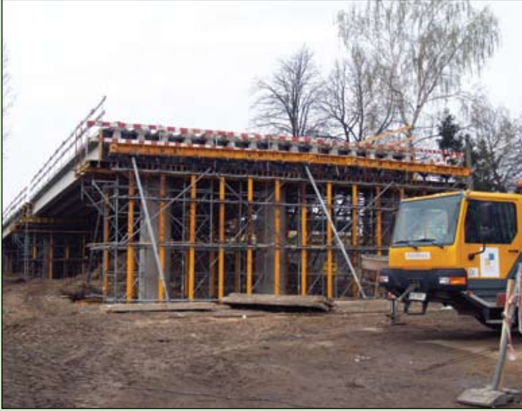
Powstaje konstrukcja nośna wiaduktu w ul. Mleczarskiej. Czy kolejny termin obiecany przez PKP PLK zostanie dotrzymany? Na spotkaniu w urzędzie miasta kierownik budowy MOTTA ENGIL deklaruje puszczanie ruchu samochodowego w lipcu.
