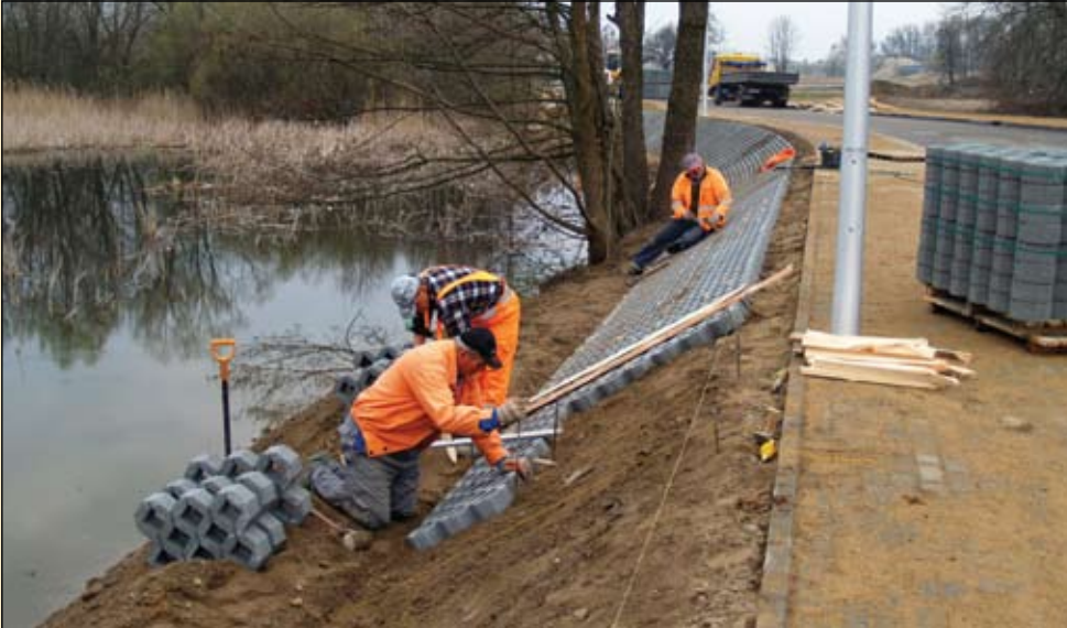
Ulica Ceramiczna. Czyżby nowa miejscówka dla wędkarzy? Czemu nie. Jak na razie drogowcy umacniają skarpy nasypu w sąsiedztwie zbiornika wodnego
