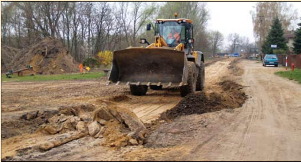
PRASBET w akcji – czyli zwijanie asfaltu i korytowanie drogi pod nową jezdnię w ul. Dobrej. Najmłodszy mieszkańcy osiedla mogą spać spokojnie, plac zabaw zostanie – to tylko tymczasowy plac składowy
