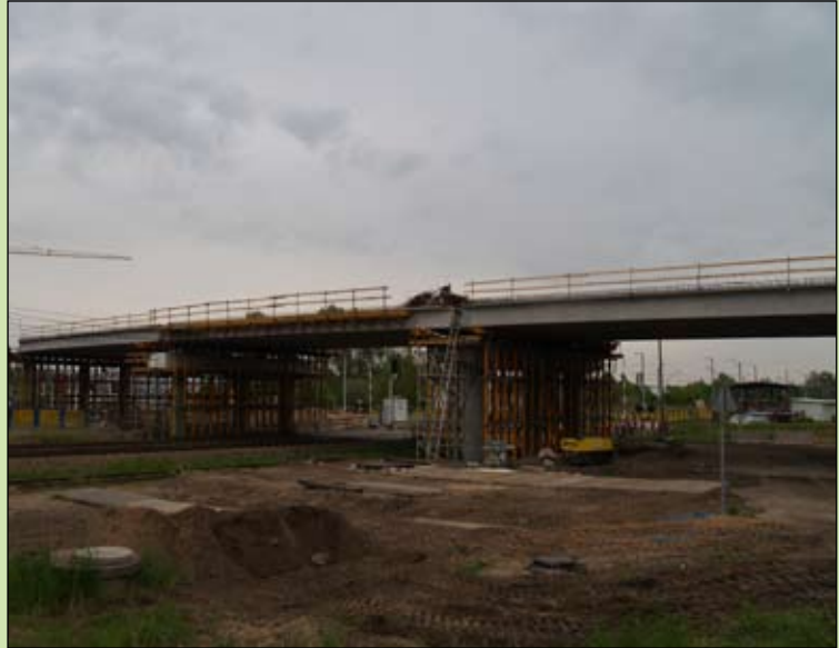
Najbardziej zaawansowane prace widoczne są przy budowie wiaduktu kolejowego w ul. Mleczarskiej. Prace przy kolejowej inwestycji mają być skoordynowane z remontem mostu na ul. Mleczarskiej.
