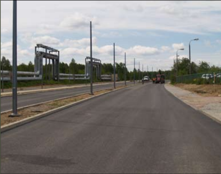
Między ulicą Niechodzką, a Płocką drogowcy wylali ostatnią warstwę asfaltu. Trwają prace porządkowe.
