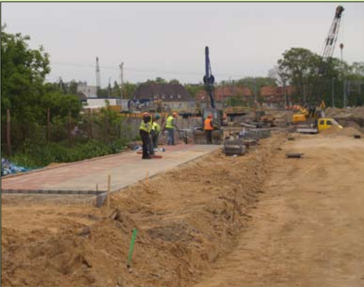
Między tunelem w ul. Spółdzielczej i Śmiecińskiej a Starowiejską drogowcy układają chodniki i ścieżkę rowerową.
