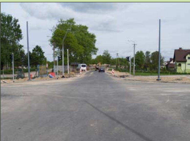
Nowe skrzyżowanie pętli z ul. Leśną. Drogowcy zamontowali lampy i sygnalizatory świetlne. W obrębie skrzyżowania układane są chodniki.
