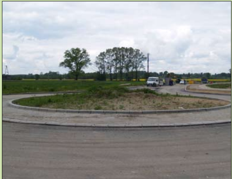
Między ulicą Kasprzaka (droga krajowa Nr 50), a nowym mostem na Bielinie powstało kolejne rondo z 13 zaprojektowanych w ramach pętli miejskiej.
