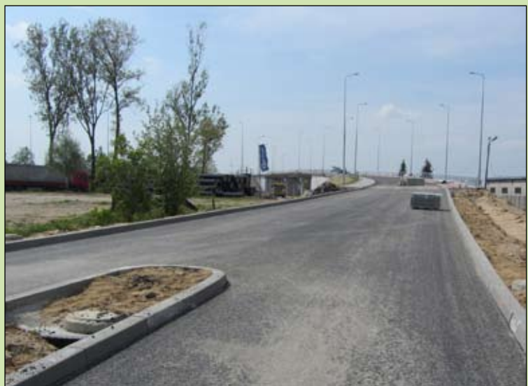
Wiadukt na ul. Gąseckiej i drogi dojazdowe do niego mają zostać ukończone do 31 maja. Nie wiadomo jednak jak długo trzeba będzie czekać na pozwolenie Wojewódzkiego Inspektora Nadzoru Budowlanego na użytkowanie wiaduktu. Dopiero po jego uzyskaniu będzie możliwe puszczenie tam ruchu samochodowego.
