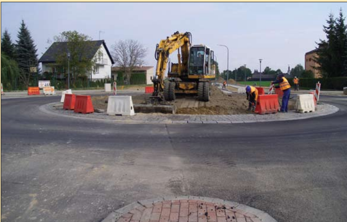
Rondo w ul. Mławskiej. Trwają ostatnie prace brukarskie
