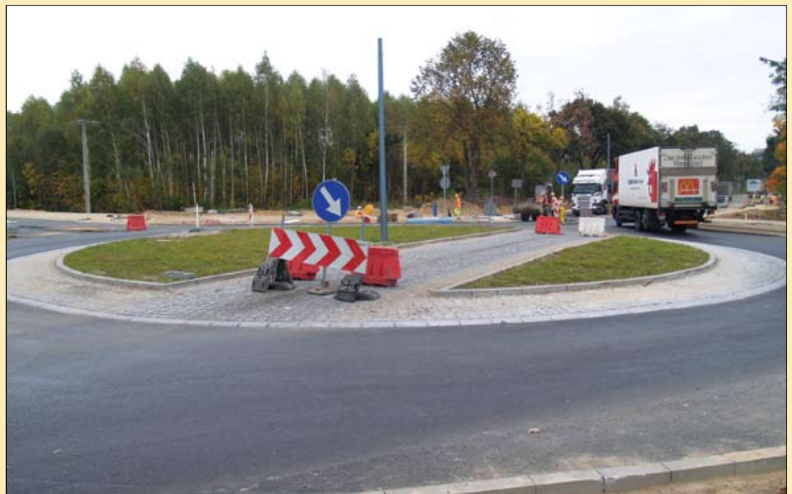
Ruch na rondzie w ul. Płockiej jest płynny
