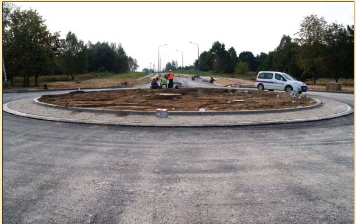
W okolicy ronda na Monte Cassino trwają ostatnie prace wykończeniowe
