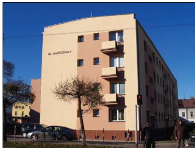
Nowa elewacja budynku przy ul. Nadfosnej 4
