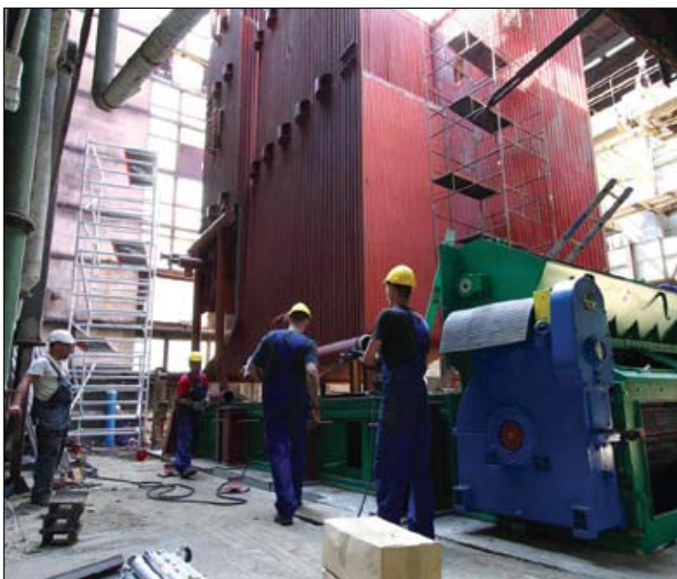
Modernizacja kotła wodnego czterokrotnie zmniejszy zanieczyszczenie powietrza
