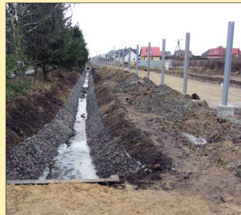
W ul. Prusa przebudowano rów i ułożono podbudowę pod nową drogę
