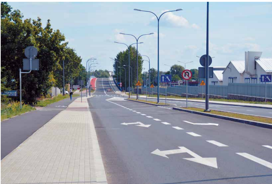
Odcinek pętli od wiaduktu w ul. Mleczarskiej do ul. Mazowieckiej
