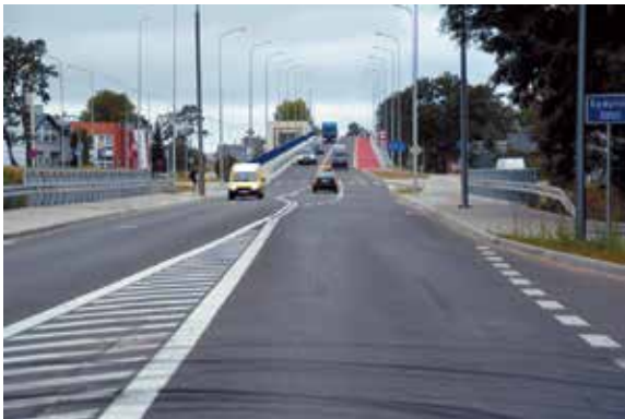
Otwarty wiadukt w ul. Młeczarskiej
