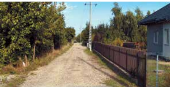
ul. Jaśminowa przed remontem
