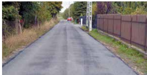
ul. Jaśminowa po remoncie
