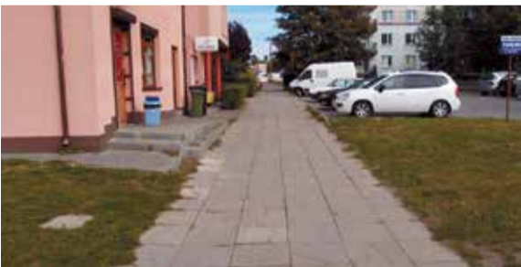
Chodnik między ul. Gwardii Ludowej a Pułtuską przed remontem
