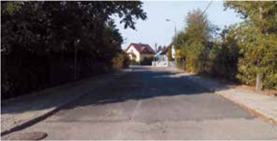
ul. Bema przed remontem
