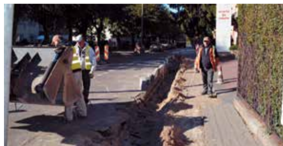
ul. Kopernika w trakcie remontu
