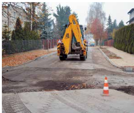
ul. Topolowa w trakcie remontu
