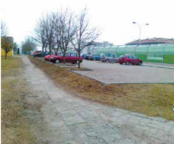
Chodnik przy ul. Armii Krajowej 43 przed remontem
