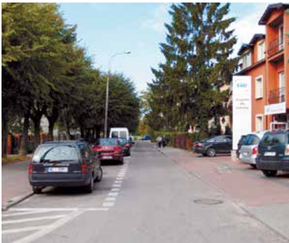
ul. Kopernika przed remontem
