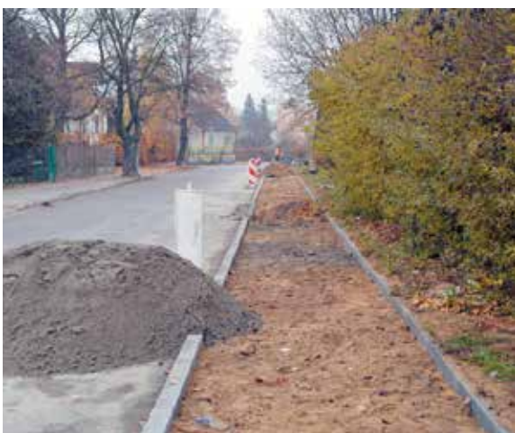
ul. Letnia w trakcie prac
