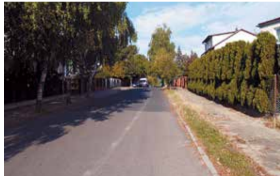
ul. Topolowa przed remontem
