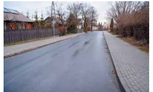
ul. Letnia po remoncie
