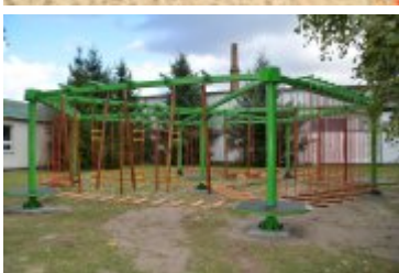
• Park linowy przy hali sportowej przy ul. Kraszewskiego
